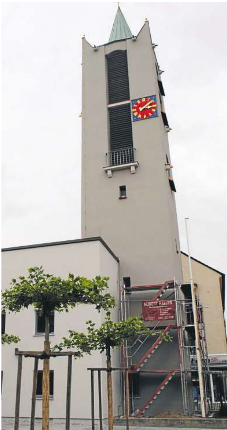
Letzte Reste des Baugerüsts stehen noch. Bald werden auch diese beseitigt. Foto: Steger
